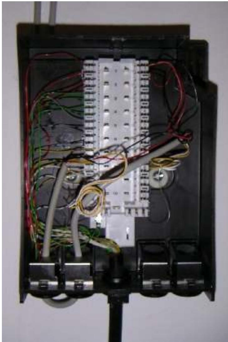
Von links kommen die Leitungen von der Telekom und rechts werden sie dann zu den TAE-Buchsen ins Haus gezweigt. Guckt wo rechts Kabel angeklemmt sind (in diesem Fall bei 1) und klemmt eure ganz einfach dazu. Damit die Kabel besser halten, mit dem kleinen Schraubenzieher etwas reindrücken. Fertig =D
